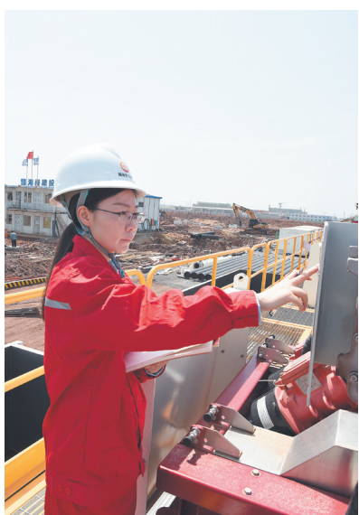
叶见玲在长沙机场中深层地热井项目现场。
