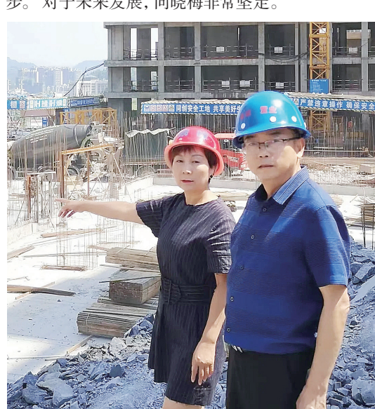
向晓梅带领公司成员检查混凝土生产情况。
