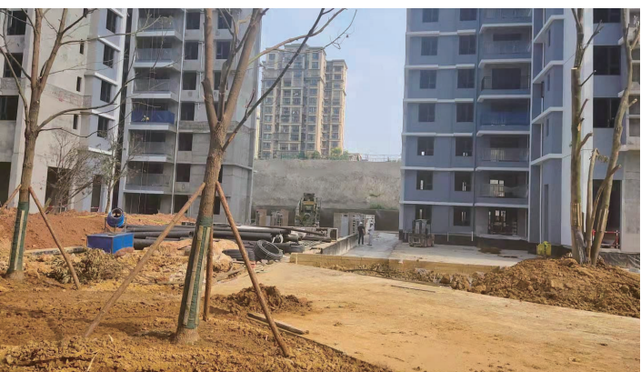
今年8月31日，原本应该是小区的交房日，小区却是黄土一片。
