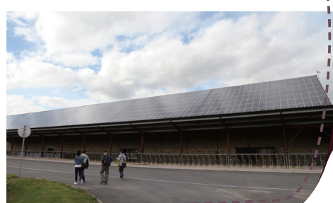
▲农场的养殖场屋顶上,有来自中国制造的 1407 块太阳能电池板。
