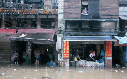
进水的商铺无法正常营业，出行受阻，一些店面受损严重。
