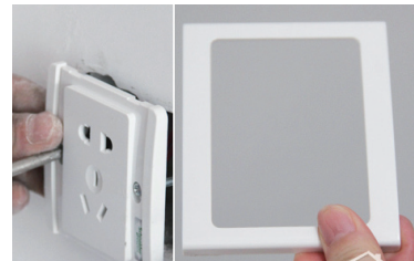
安装固定：用螺丝固定固定架，然后扣上开关插座面板。
